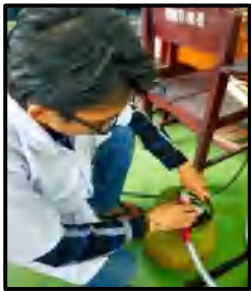
Pemasangan Gas LPG
