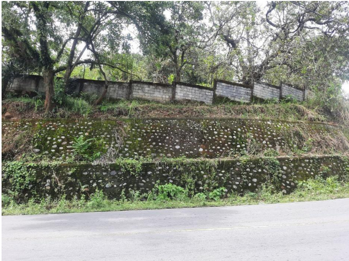
Pembuatan dinding beton ditebing
