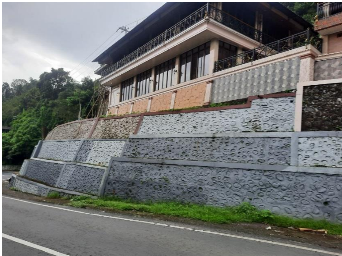
Pembuatan dinding beton dipinggir jalan
