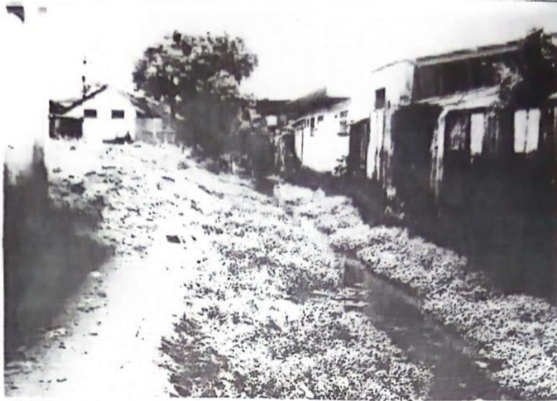
Salah satu dari selokan yang ada di belakang RS. Pelamonia, yang sulit di gali, akibat tidak memiliki jalan Inspeksi. (Photo, PR-Ardhy).
