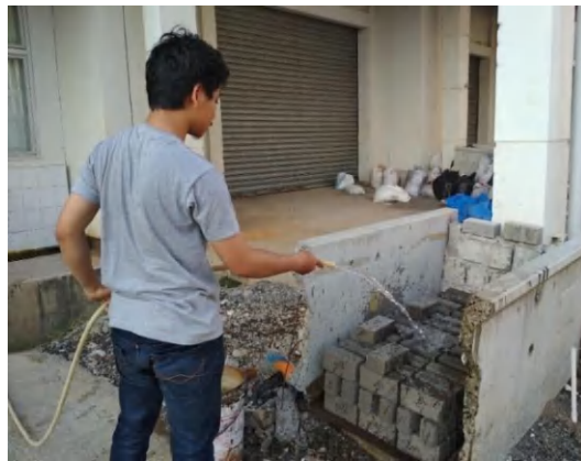
Perawatan paving block dengan cara disiram setiap hari dengan air selama 28 hari
