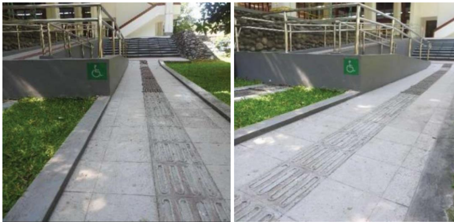
Gambar 24 Jalur pedestrian dengan blok pemandu yang memudahkan pengguna disabilitas
