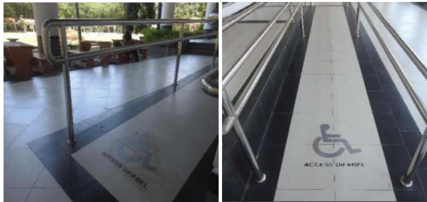
Gambar 23 Jalur pedestrian ramah disabilitas yang dilengkapi fasilitas pegangan tangan
