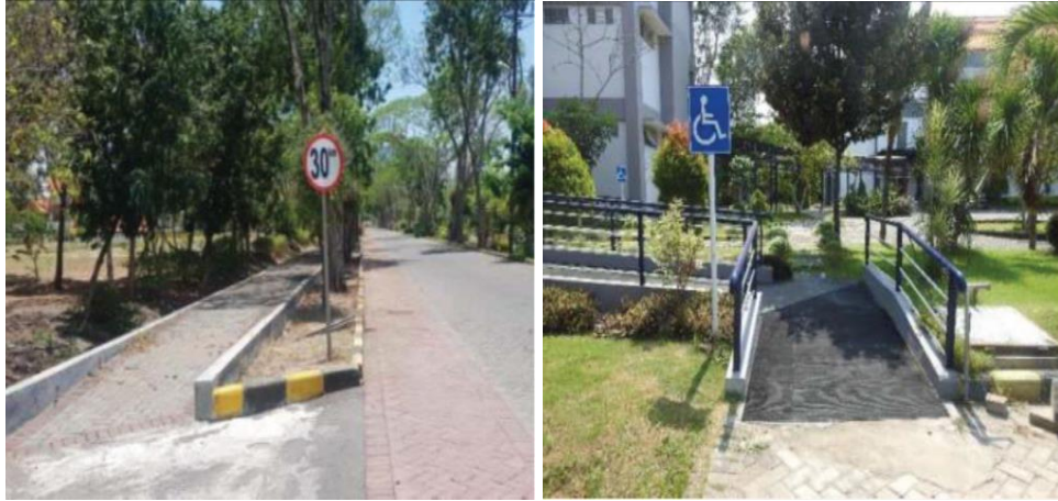
Gambar 22 Jalur pedestrian ramah disabilitas dengan tanjakan pengganti tangga yang landai
