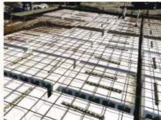
Rangka Plat Beton
