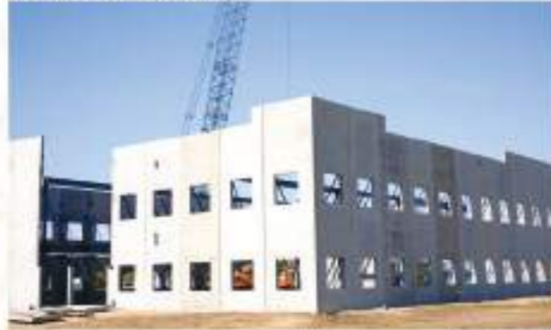
Kolom dan Balok Pracetak
