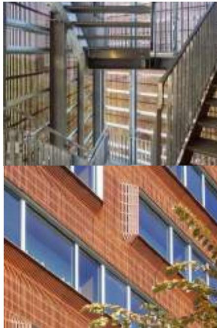
**Gambar 2.21** Lembaran logam berlubang pada fasad
