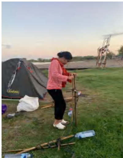
(D) Pemasangan Rangka Sedimen Trap
