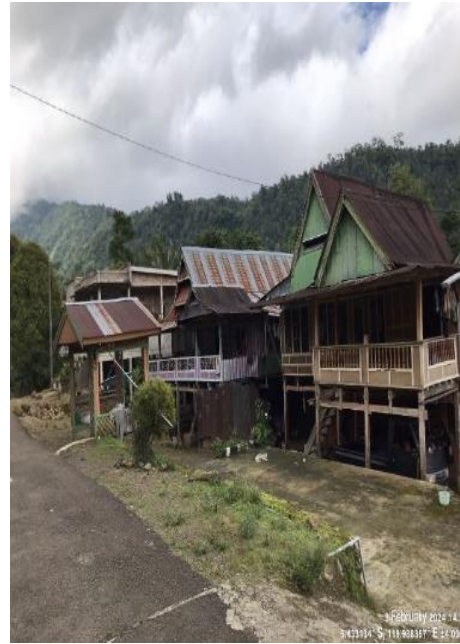
(b) Ground check kondisi penutupan pemukiman
