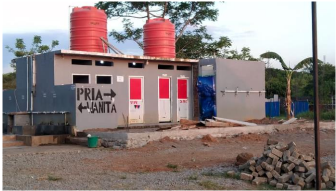
Toilet Pantai Indah Bosowa
