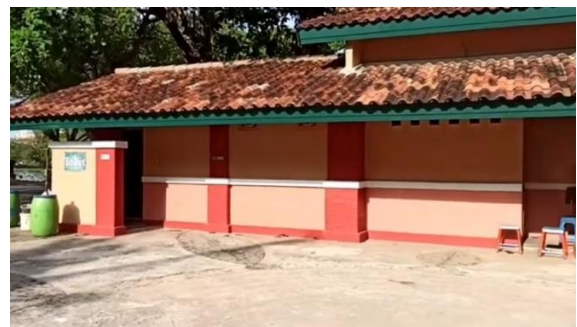
Toilet Pantai Akkarena
