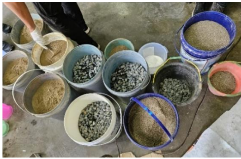
Lampiran 1 Persiapan material untuk pengecoran beton geopolymer
