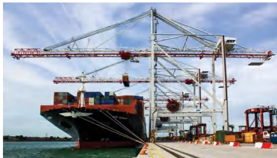
Gambar 2.7 Peralatan Bongkar Muat Container Crane
