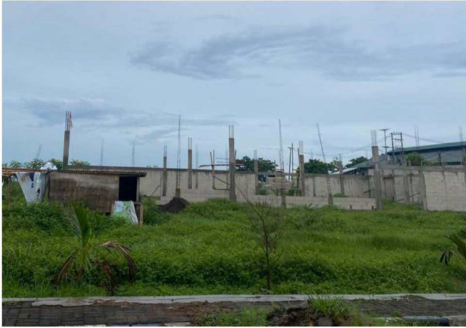
Bangunan dalam proses pengerjaan di lahan PPN Untia
