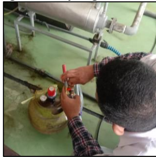
Pemasangan gas LPG
