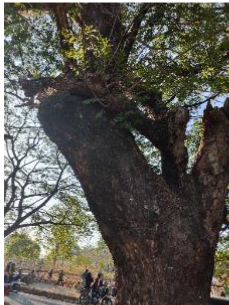
Pengamatan lokasi kerusakan
