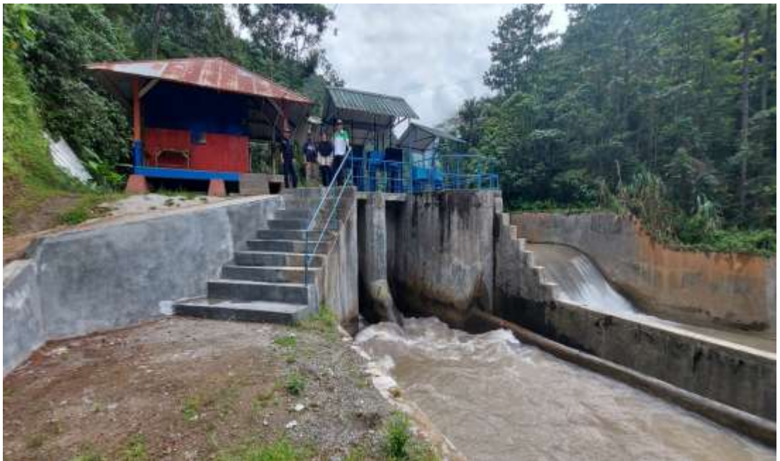
Gambar4. Bendungan dan Bak Pengendap PLTM Ranteballa Desa Ranteballa Kecamatan Latimojong Kabupaten Luwu
