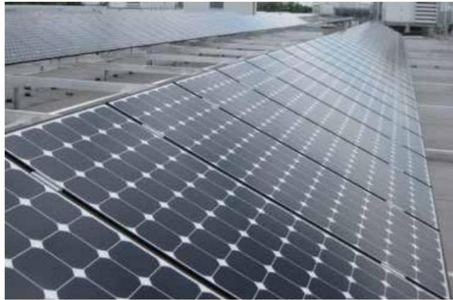
Gambar 9 Tampilan modul PV mono-crystalline (RENAC dkk., 2020)
