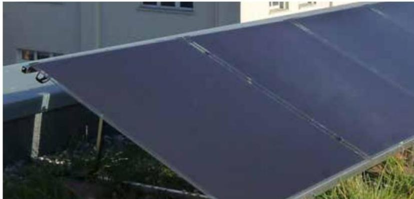
Gambar 12 Tampilan contoh pemasangan modul PV amorphous (RENAC dkk., 2020)
