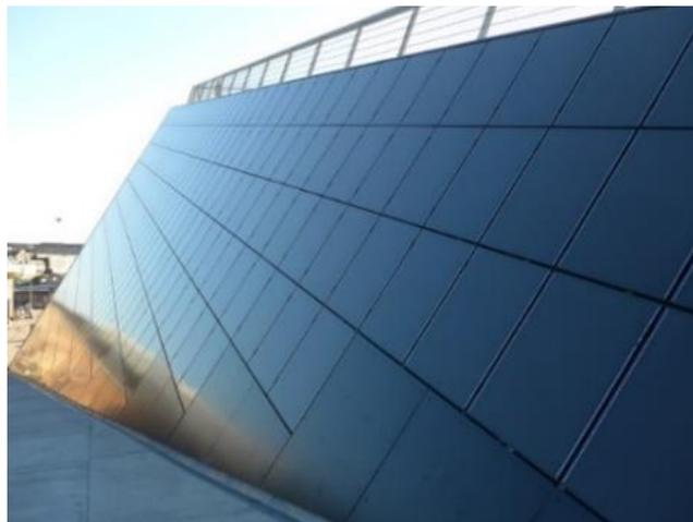
Gambar 14 Tampilan contoh pemasangan modul PV CIGS (Brusdeylins, 2021)
