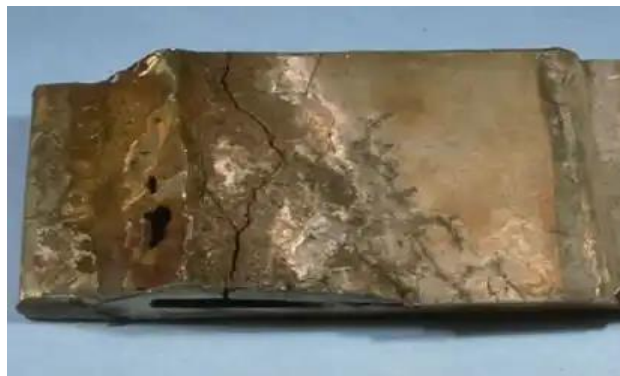
Gambar 2.9 Korosi Tegangan (Sumber : theconstructor.org)
