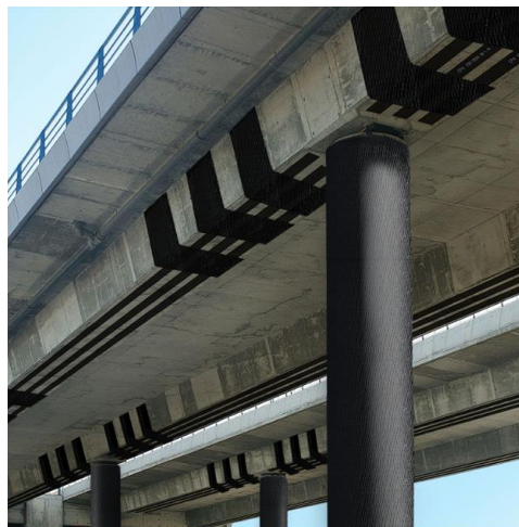
Gambar 15. Perkuatan struktur dengan FRP (sumber: ptatm.id)
