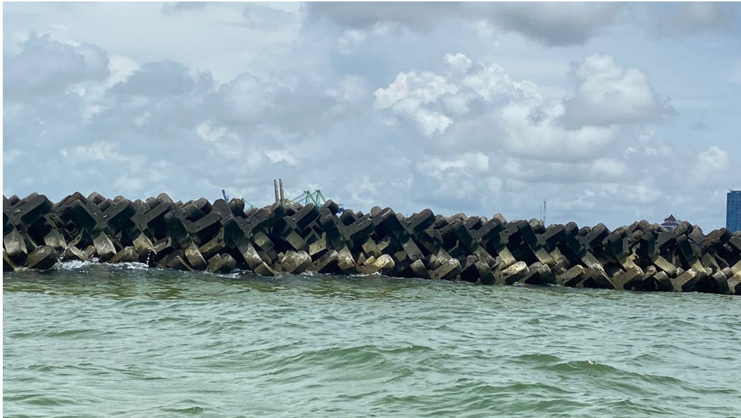
Lampiran 3 Gambar pemecah gelombang di pulau Lae Lae
