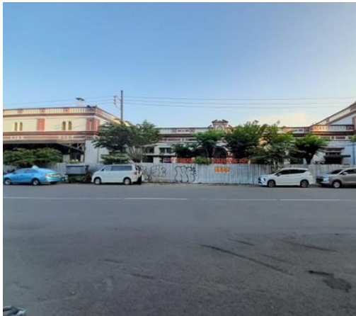
Foto 4. 27 Tampak Utara bangunan Stasiun Surabaya Kota (Dok. Juan Steven Susilo, 2022)
