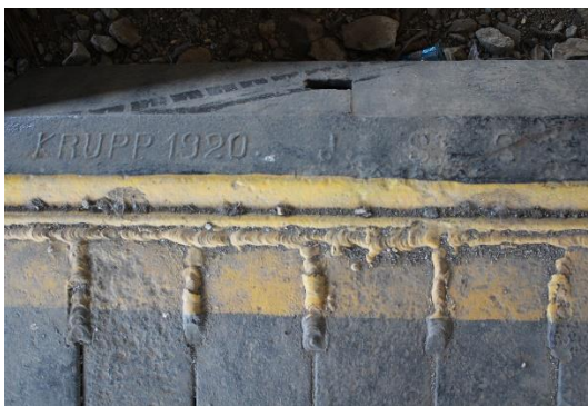
Foto 4. 34 Nama Pabrik Industri
