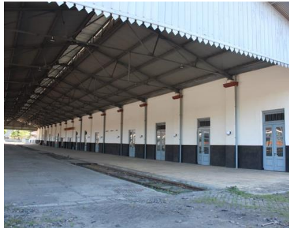
Foto 4. 28 Tampak Barat Bangunan Stasiun Surabaya Kota (Dok. Marselina Rante, 2022)
