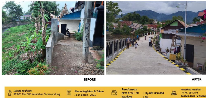
Gambar 4.8 Pekerjaan Jalan Lingkungan Oleh Program KOTAKU Tahun 2021
