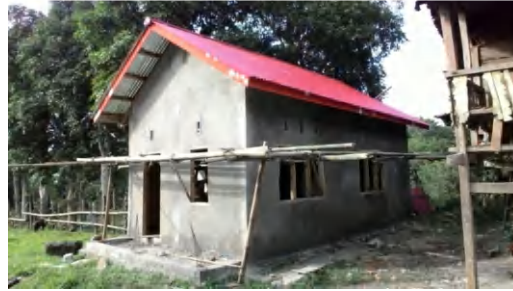
Kegiatan Pembangunan Poyandu 80% ( 5x10 M) di DesaMataaloKec.Alla yang menggunakan Dana Desa , Nopember 2017
