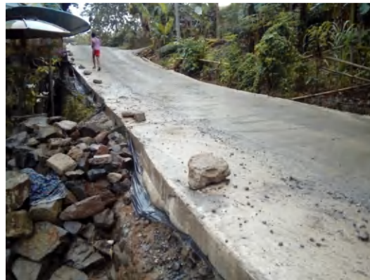
Kegiatan Pembangunan Jalan Beton 100% (3x 500 M) di Dusun Padukku Desa Pundi Lemo Kec. Cendana yang menggunakan Dana Desa, Nopember 2017
