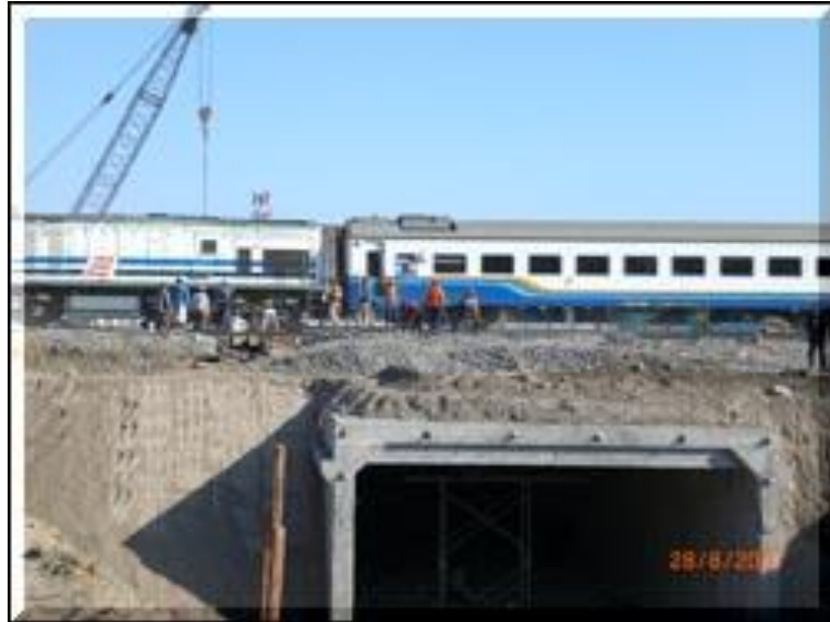
Gambar 2.3 Box Culvert Di Bawah Lintasan Kendaraan
