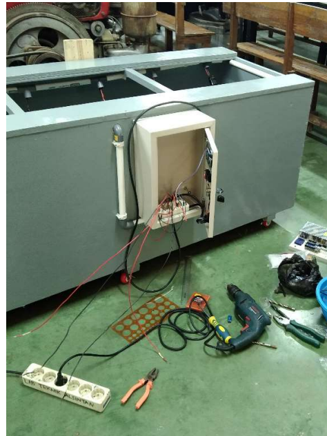
Penginstalan kelistrikan dan kontrol pada inkubator
