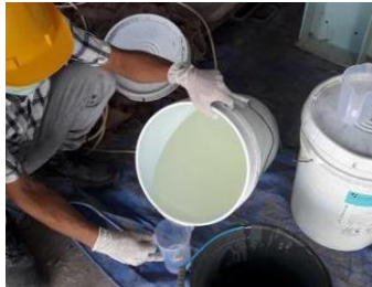
(d) Pencampuran epoxy resin
