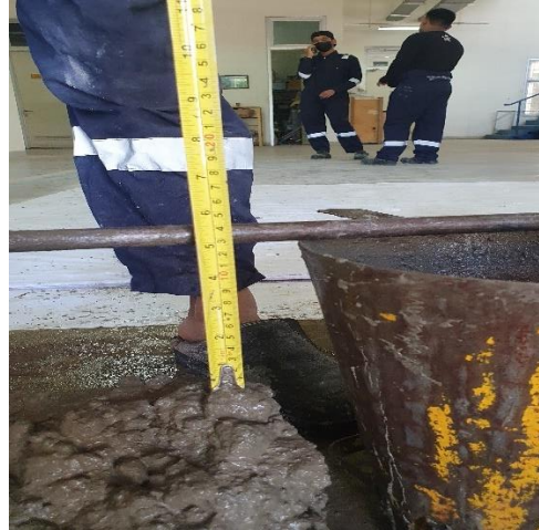
(b) Pengukuran Slump
