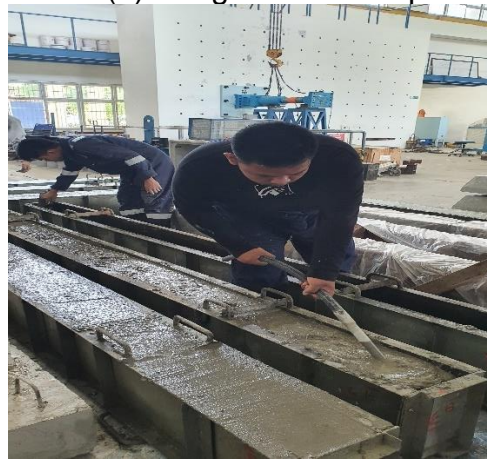
(a) Pemadatan beton
