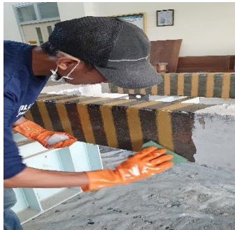
(g) Menutup pori dengan acian epoxy resin+aerosol
