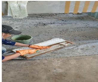
(e) Pengolesan epoxy resin ke GFRP sheet
