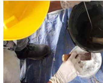
(f) Pembuatan acian dari epoxy resin + aerosol
