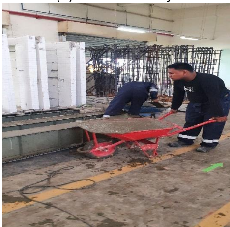
(c) Penuangan beton ke bekisting
