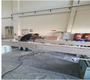
(a) Permukaan dikasarkan dan tepi balok dibulatkan
