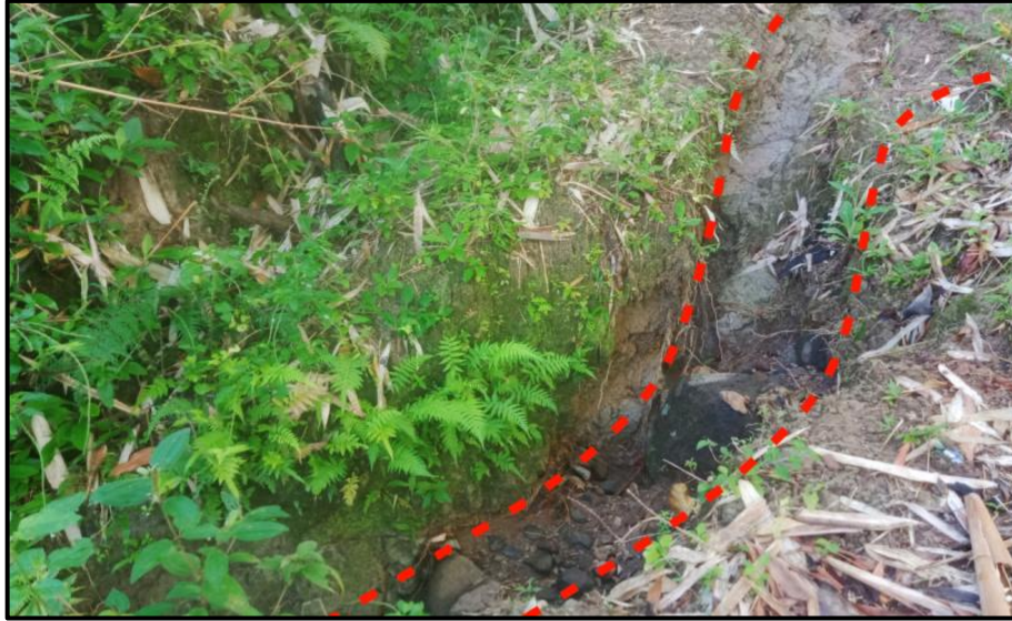
Gambar 13 Kenampakan rill erosion stasiun 23 dengan arah foto N255° E
