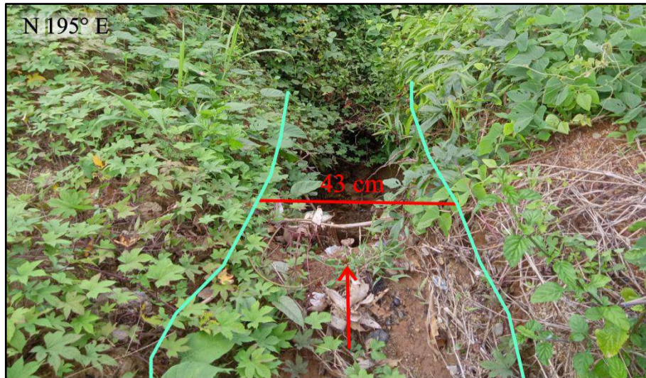
Gambar 8 Rill erosion dengan lebar kurang lebih 43 cm, pada stasiun 46 dengan arah foto N 195° E Daerah Awota
