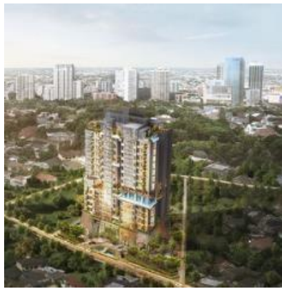
Gambar 2. 12 Suasana eksterior bangunan
