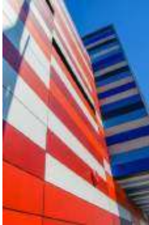
Gambar 2 Fasad bangunan Garry Comer Youth Center
