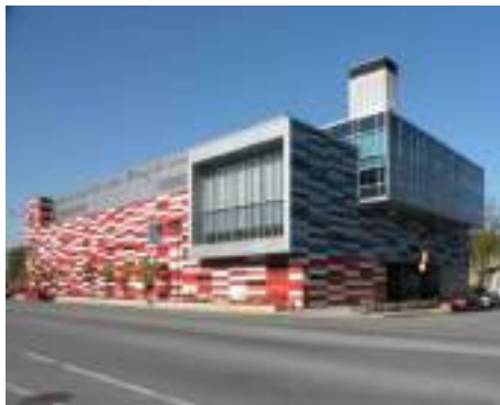
Gambar 1 Tampak bangunan Garry Comer Youth Center
