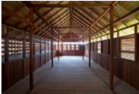
Gambar 17 Penggunaan material kayu pada ruang komunal di bangunan pesantren.
