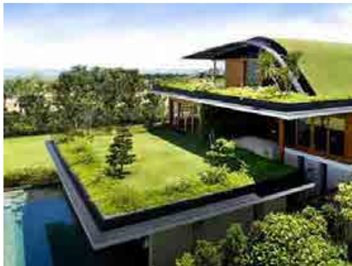
Gambar 11. Taman di atas atap guna mengganti lahan hijau terbangun
