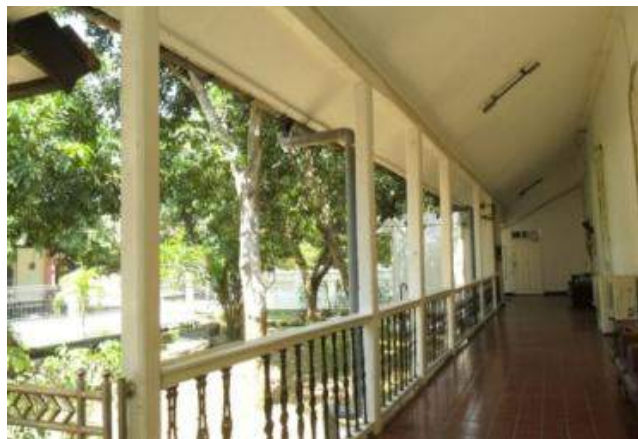
Gambar 2. 8 Contoh Balustrade pada Bangunan Kolonial
