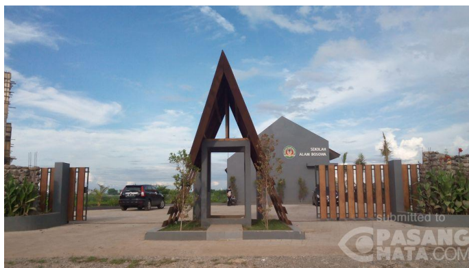
Gambar 14 Bangunan Sekolah Alam Bosowa di Makassar
