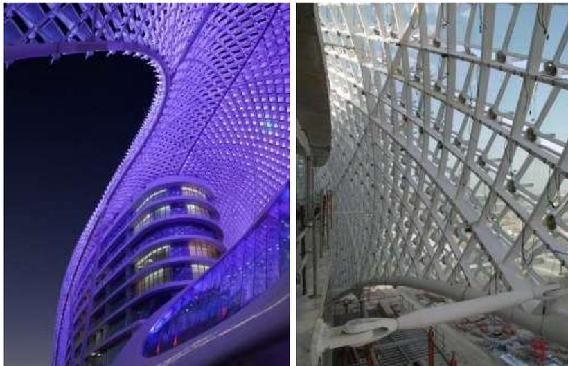
Gambar 45. Penampilan komponen *grid-shell*.
