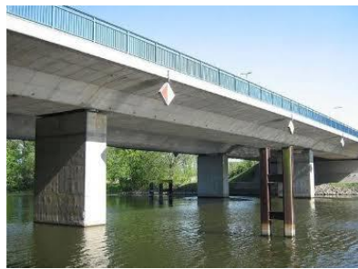
Gambar 3 Beton massa (jembatan)
