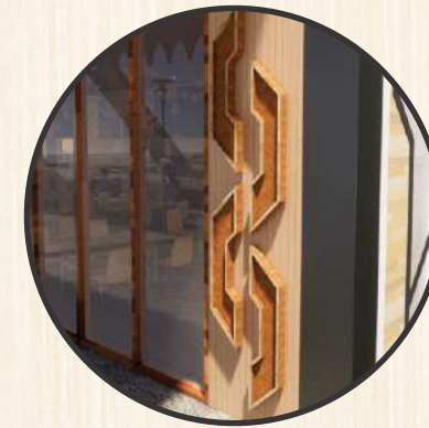
Penerapan material ACP pada bagian dinding bangunan dengan pola batik khas Suku Tolaki yang bertujuan untuk menambah nilai estetika pada bagian ruang luar.
