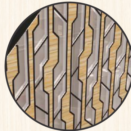
Penerapan material ACP dan kaca tempered pada bangunan berfungsi sebagai fasade dengan pola batik khas Suku Tolaki yang menambah nilai estetika pada bangunan.
