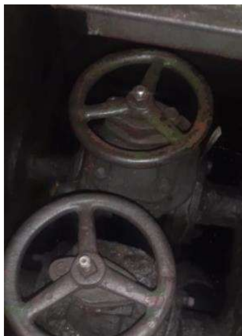
Gambar 4.8 Valve Fresh Water sebelah kiri dan kanan jumlahnya 2 pcs
