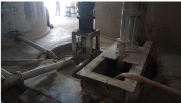
Lampiran Gambar 3. Sumur Penampungan
