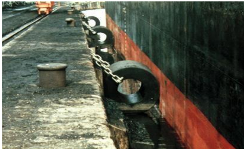
Gambar 2.4 Fender gravitasi
