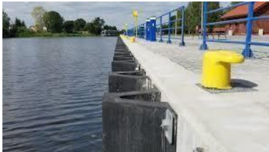
Gambar 2.5 Fender karet pada dermaga
