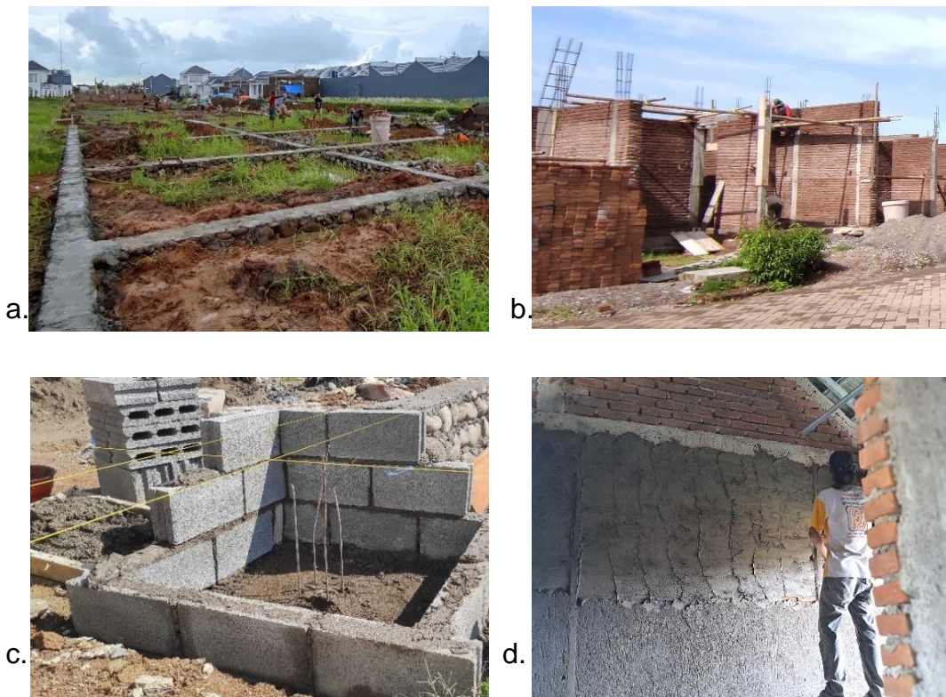
Gambar 1. Pengaplikasian Mortar di lapangan. a. Aplikasi pondasi batu kali; b. Aplikasi dinding batu bata; c. Aplikasi batako; d. Aplikasi Plasteran dinding
