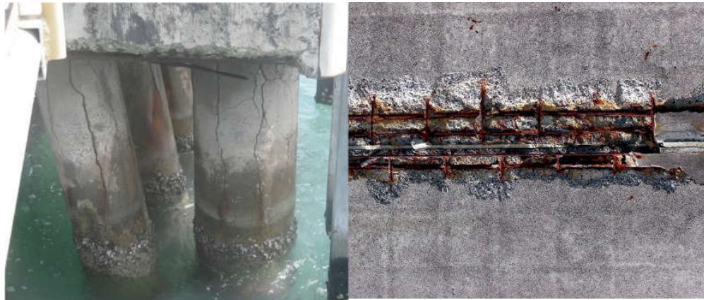
Gambar 1 Kerusakan konstruksi beton
