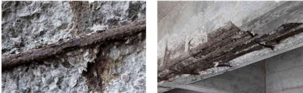
Gambar 3 Spalling pada Beton
