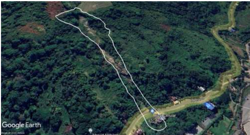
Lokasi kejadian longsor rotasi pada tahun 2023
