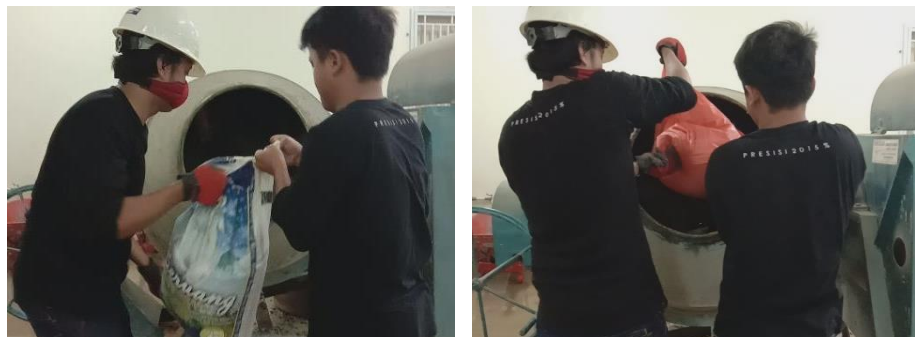
Gambar 7. Pencampuran material beton
