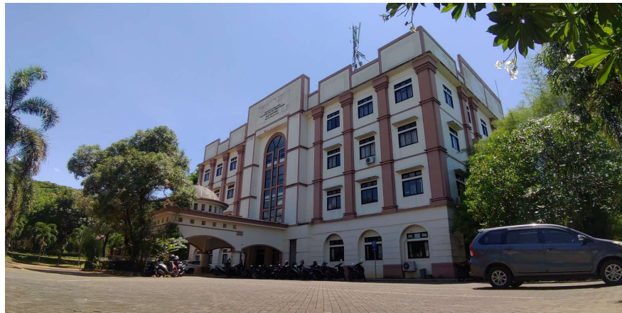
Gambar 16 Gedung Perpustakaan UIN Alauddin Makassar
