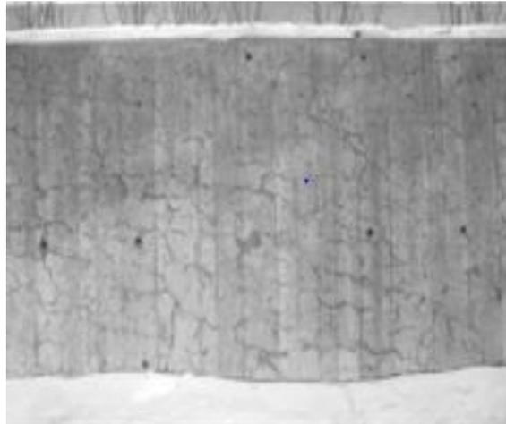
**Gambar 3.** Retak di Dinding Penahan
