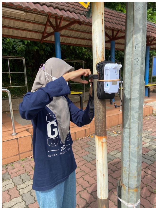
9a. Pemasangan alat pada lokasi pengukuran
