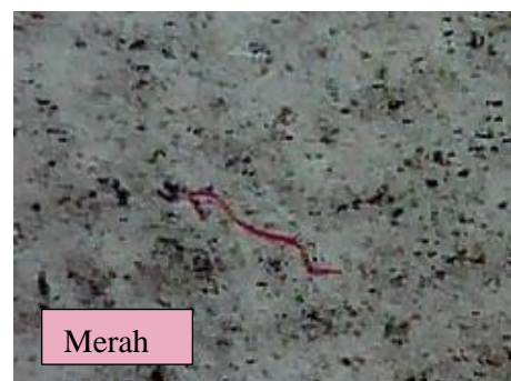
Lokasi: Jalan Akses Kawasan CPI
