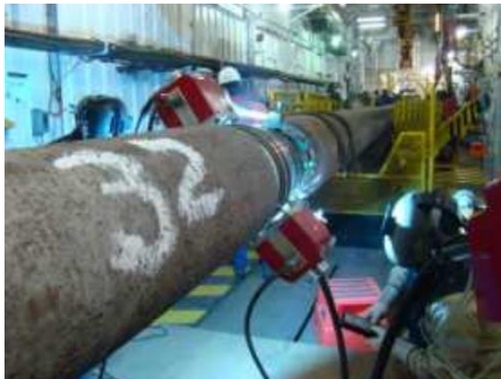
Gambar 12 Pengelasan pipa bawah laut
