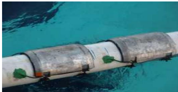
Gambar 20 Proteksi Katodik pada pipa bawah laut
