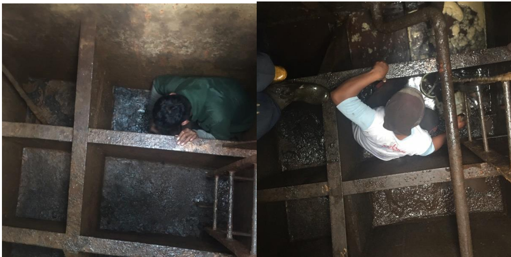
Gambar tank cleaning pada tangki ballast
