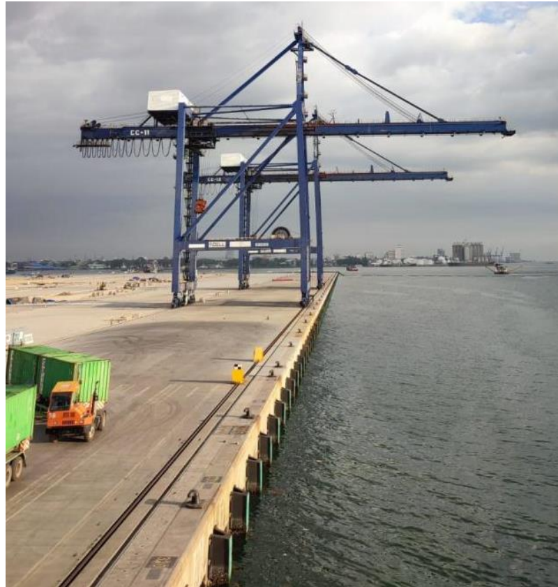
Gambar 2.1 Dermaga Terminal Peti Kemas New Makassar Terminal 2 Sumber: Dokumentasi Pribadi
